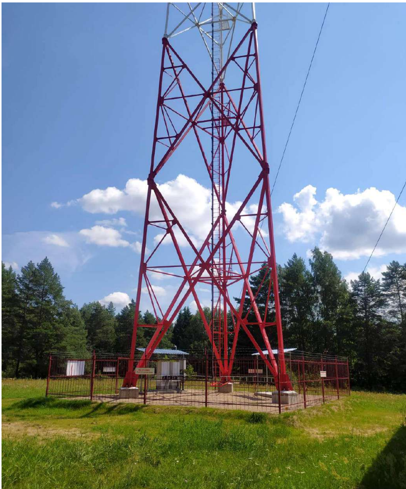
Рисунок 11 – Площадка под установку БС
